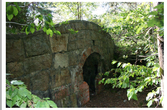
Bilde av bunkers ved R113379, F2 sett mot N.
