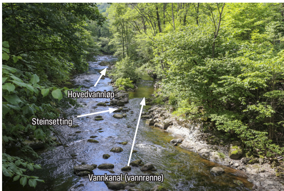
Hamang gård teinested. Sett motstrøms fra brua over Sandvikselva i Bjørnegårdsvingen ved Hamang.
