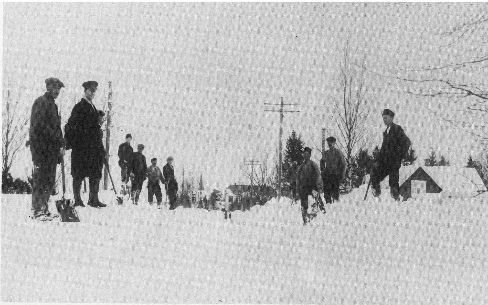
Sandersletta ble håndspadd i 1930. Det ble ofte for mye snø for hester og plog på denne veien. Bildnr. a79/93-1.
