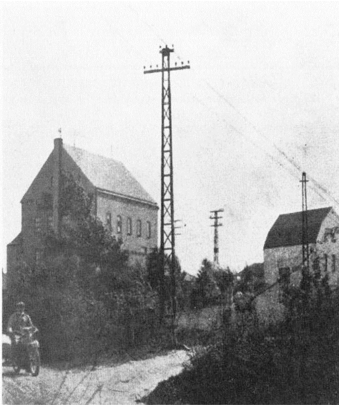
(Venstre bilde) Trafostasjonen på Skiseng.
