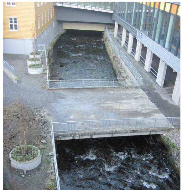
Figur 9 Nesttunelven i Nesttun sentrum er kanalisert, delvis lukket og har kunstig redusert avløpstverrsnitt.
