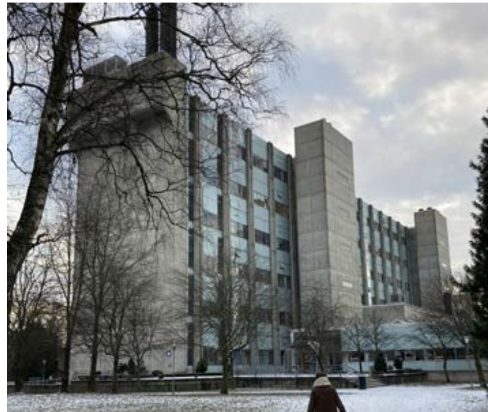
Labatoriebygget, blodbank, ferdig i 1976-1980. Fredet.
