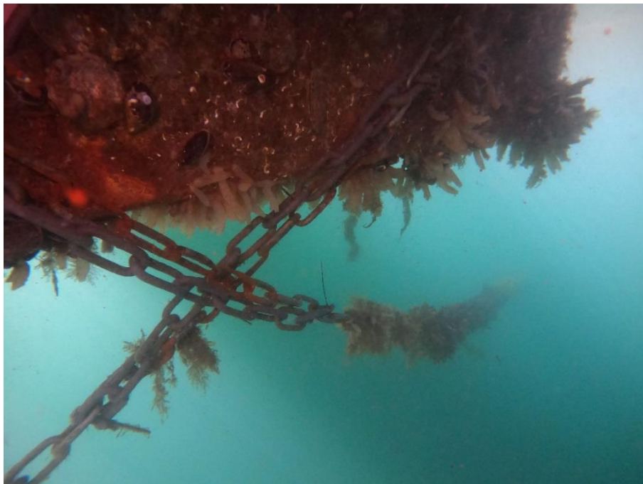
Bilde 5 – Eksempel: Kjetting kryss hvor begge originalkjettingene er sikret med nye kjettinger.
