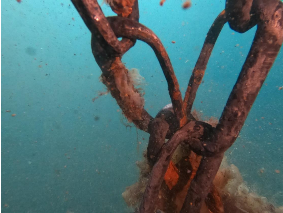
Bilde 6 - Eksempel på slitasje hvor kjettinger er i kontakt med hverandre.
