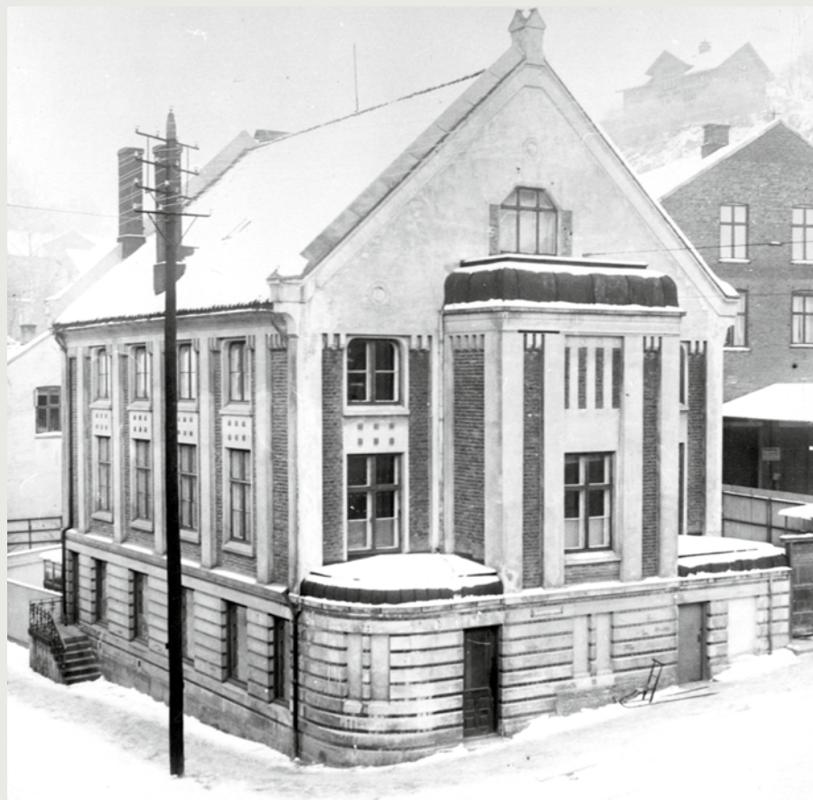
Den gamle telefonsentralen i Kongensgate 16, Skien. Foto: R. Nyblin
