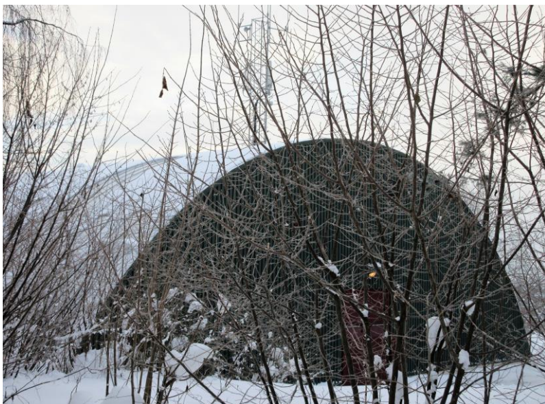
Rykkinnhallen med lengre fartstid enn de fleste på Rykkinn. Ble bygget som lagerhall når nye Rykkinn skulle bygges ut og overført til Bærum kommune når byggeperioden var slutt. (Foto:ES)
