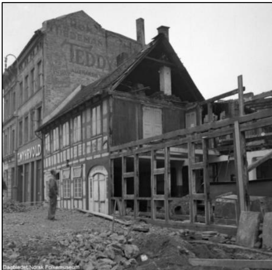
Under; demonteringen av bindingsverkshuset Rødfyllgata 12 i 1957 eller 1958.
