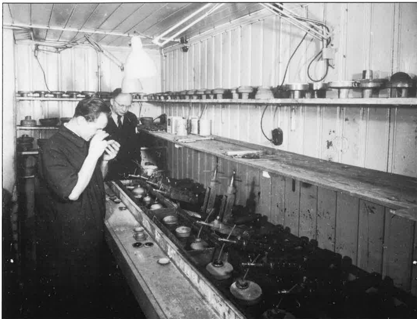
År 1949. Fra det første sliperiet i Storgt. 20, bryggerhuset i bakgården. Fra venstre F. Kulisek og Anders Spiten. Her foregår sliping og polering av brilleglass på den egenproduserte "langbenken".
