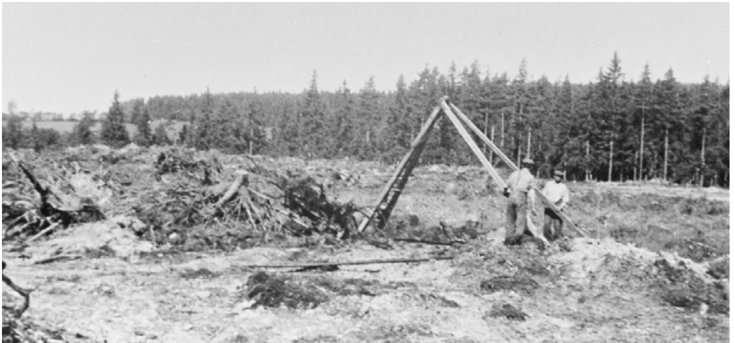
Dugnadsarbeidet på Bruvollen startet med stubbebryting. Foto: Sørum Fotosamling
