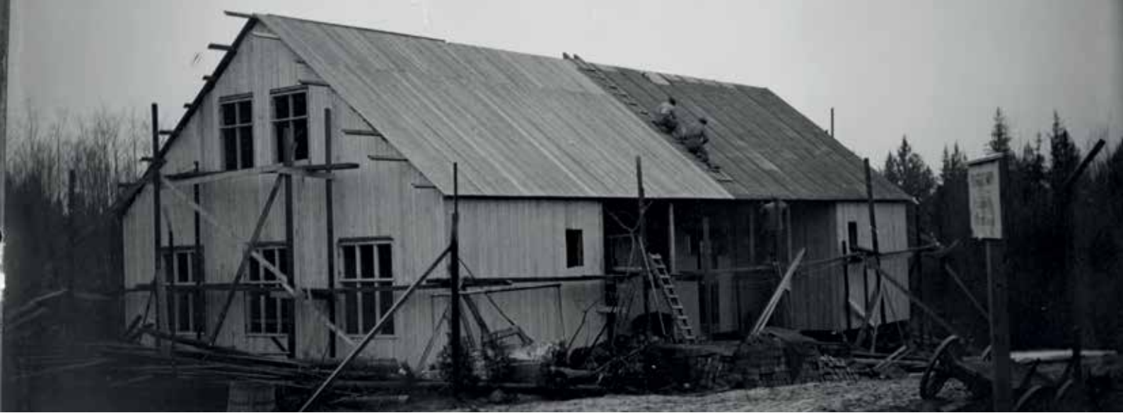
Bygging av den «foreløpige skolen» på Rånåsfoss i 1918. Foto: Brukt med tillatelse fra Norsk Teknisk Museum.
