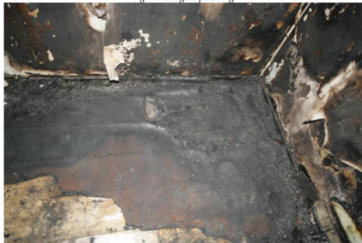
Figur 3. Förkolning av golv under säng.
