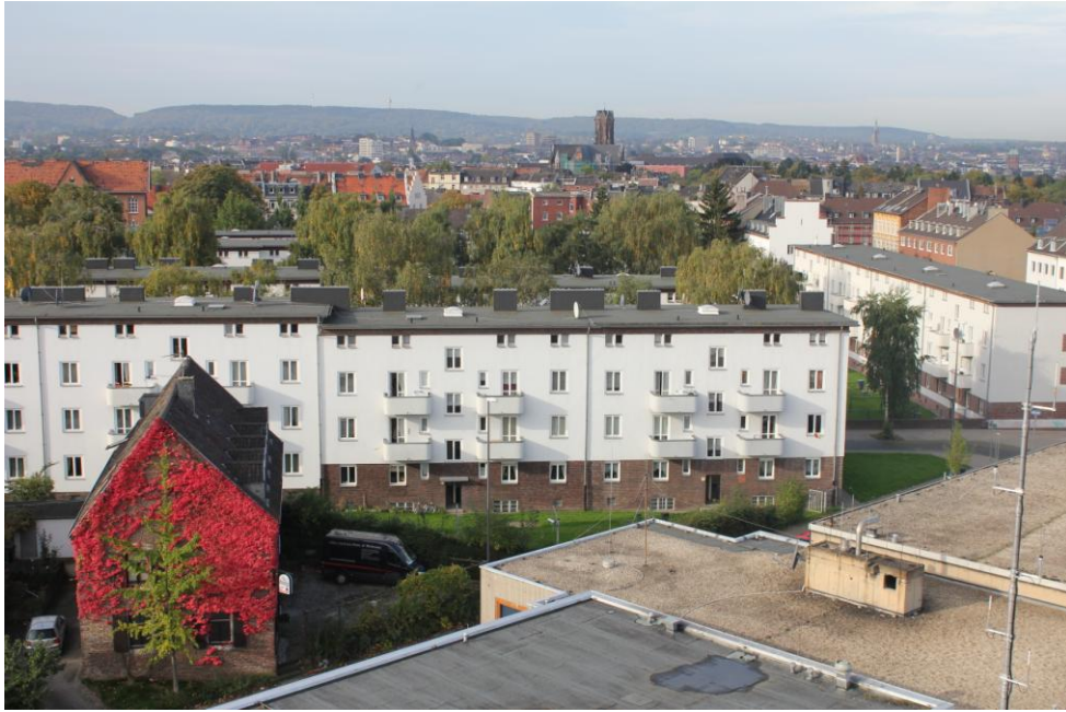
Leiligheten og byen Aachen sett fra brannstasjonen
