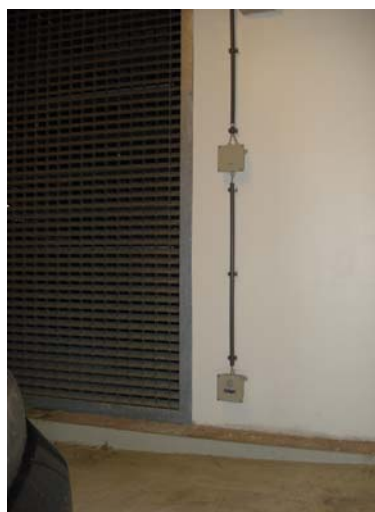
Detektorer for CO (øverst) og LPG/propan (nederst) plassert ved avtrekkspunkt i hver etasje.
