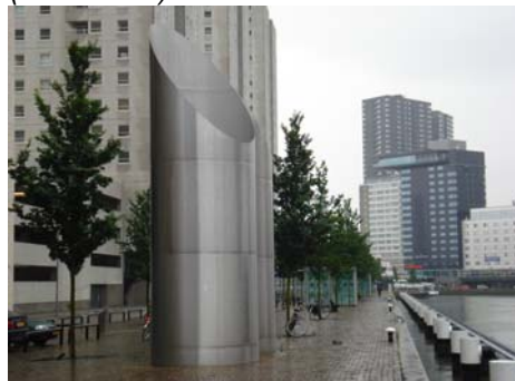
Utkast (2 stk.) fra avtrekkssjakter (Rotterdam)
