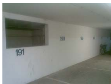
Utlufsåpning i yttervegg i parkeringskjeller.
