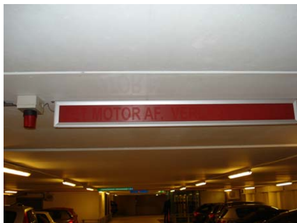
Strobelerampe og lysskilt.
