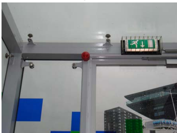
Strobelermer plassert øverst i trappenedganger, synlig fra utsiden.
