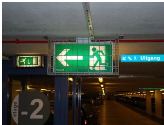
Det røde perforerte røret er en egen sløyfe på aspirasjonsanlegget.
