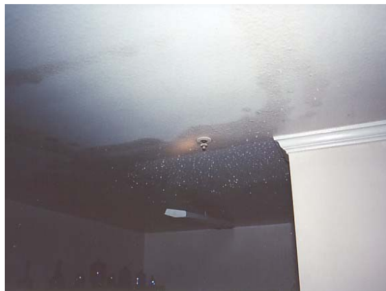
Sprinklerhodet som slokket brannen.
