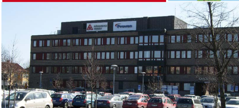
Räddningsverket i Karlstad
