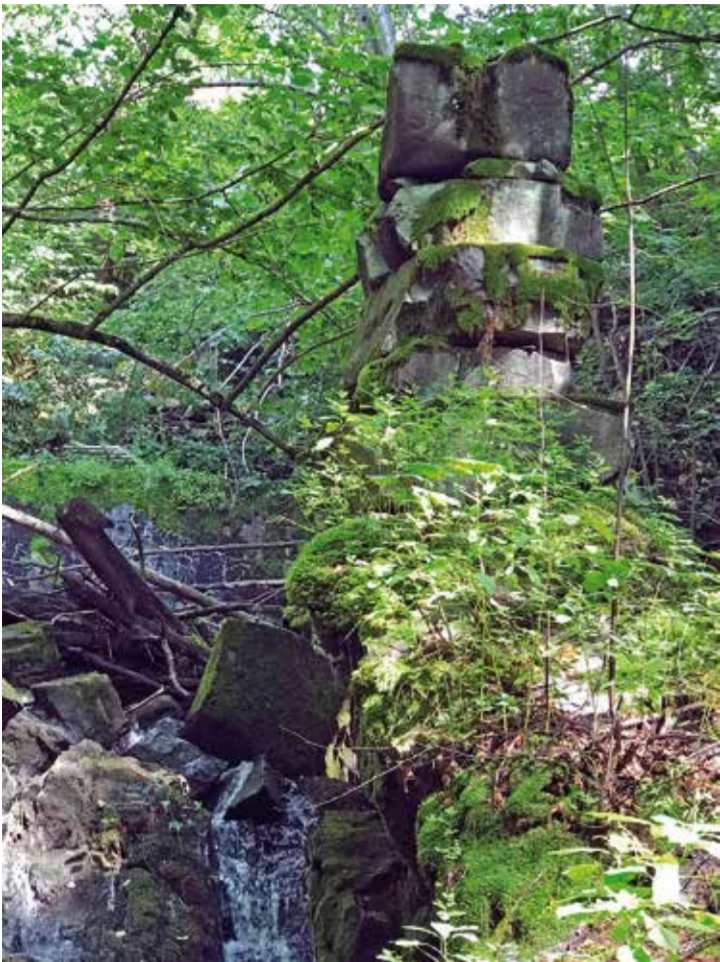
Det er få spor i dag av de gamle kvernene langs elva. Men i Kvernfossen ved Løkeberg står denne pilaren etter en vannrenne. Se punkt 21 på andre siden. Foto Solveig Emilsen
