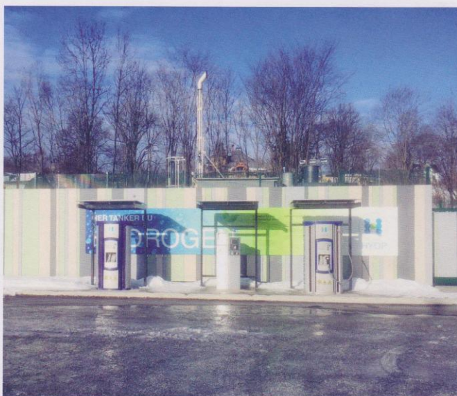
Hydrogenladestasjonen, som kom i november 2017, i Sandviksveien på Høvik.
