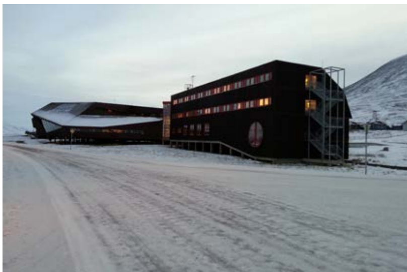
Svalbard Science Center Som de fleste bygg er dette også bygd på påler for at permafrosten under ikke skal smelte og ødelegge bygget.
