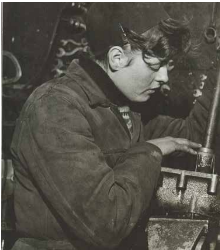
Med håret dyttet inn i farens borsalinohatt og hendene ned i en motor trivdes Grete på jobb. Utklipp utlånt av G.K.
