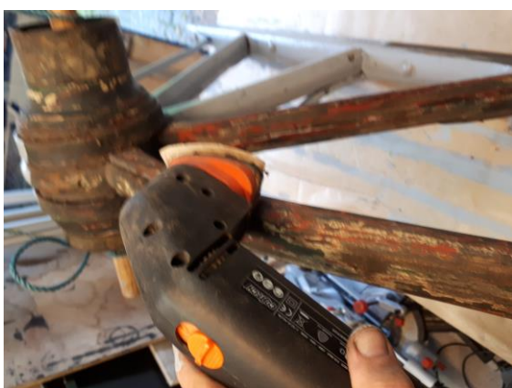
Grundig sliping fjerner malinglass
