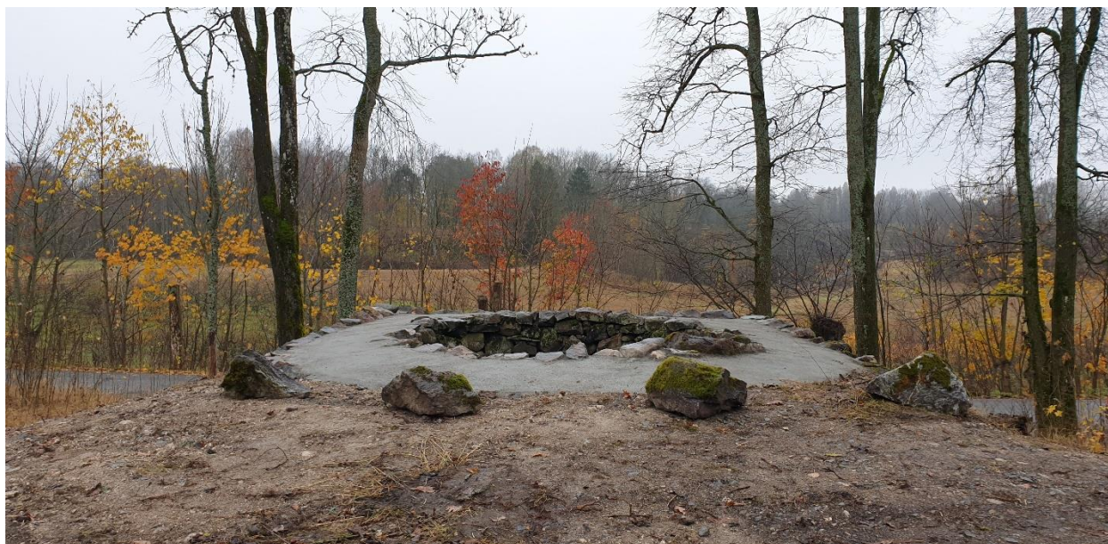
Foto: Ringi kalkovn - Etter støping av ny ring rundt toppen.
