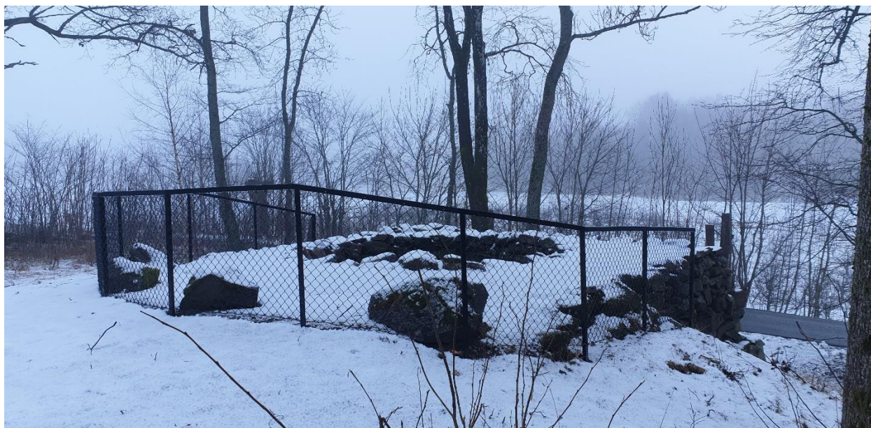
Foto: Ringi kalkovn – Etter montering sikkerhetsgjerde
