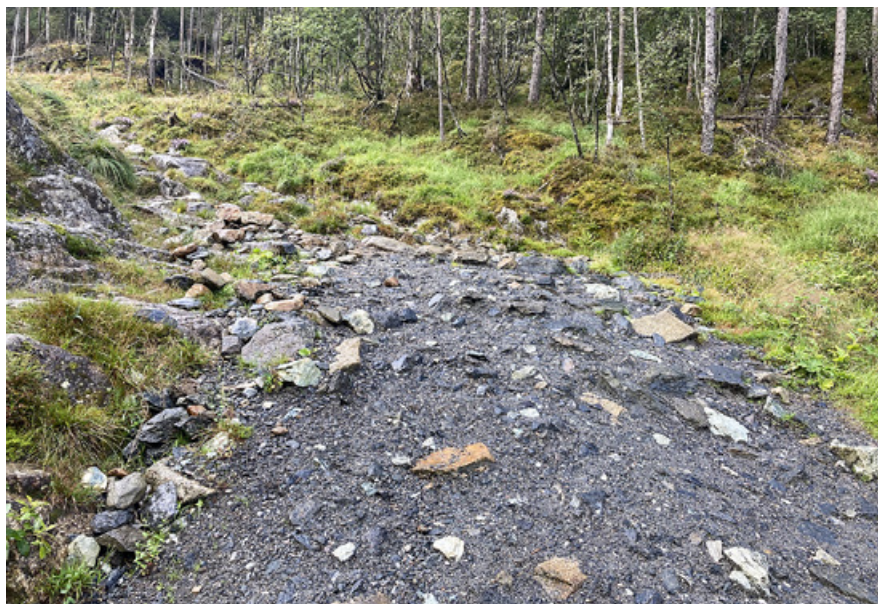
Før opprustning i skaret ved «Skillingsbollen».
