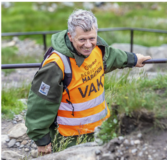
Erling som vakt under anleggsarbeidet i Oppstemten.
