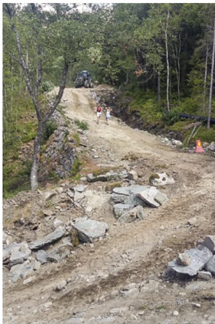
Skiveien før opprusting.
