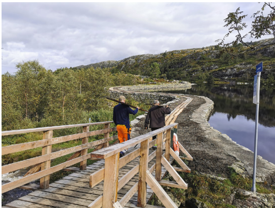
I løpet av beretningsåret har selskapets ansatte på vegne av Bydrift arbeidet på demningen Storevatnet sør.
