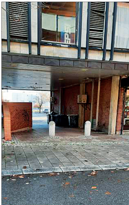
Portrommet under Arild's ligger mellom Kjell A. Mysens og tidligere Arild's stormarked.
