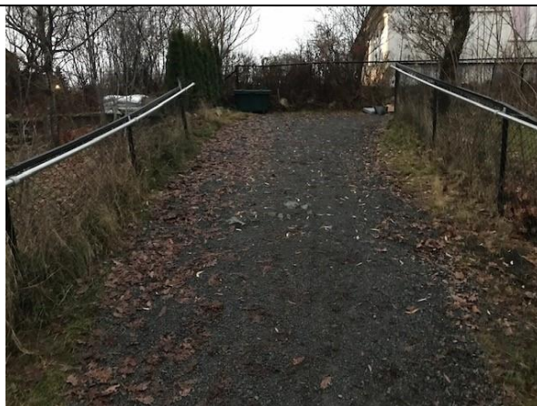
Figur 2 - Rekkverk på plass BB/EV
