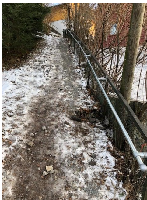
Figur 4 - Rekkverk montert RT/EV
