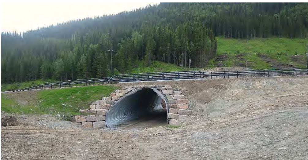
Figur 15: Kulvert under hovedveien Totteskogen, sett fra nord. På andre siden ligger den nye skiløypa.
