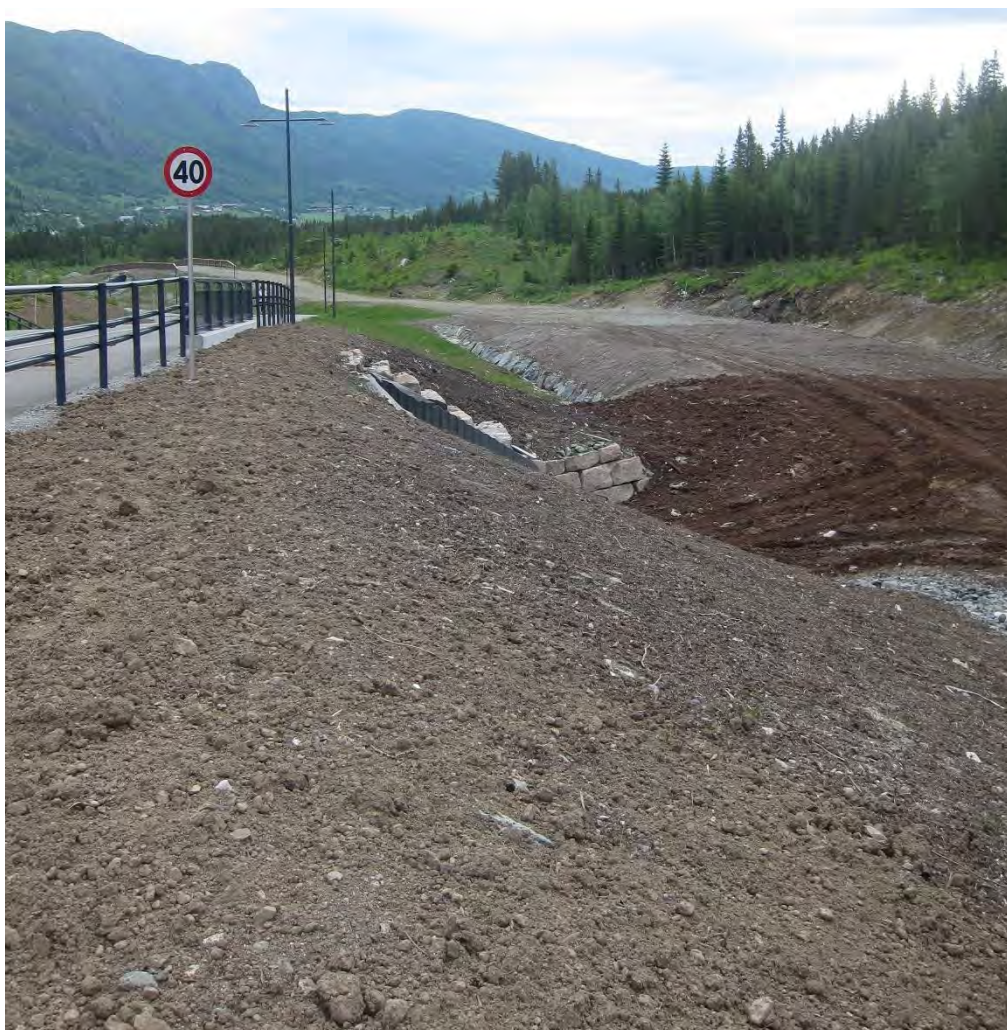
Figur 24: Bildet viser skikulvert som gir tilkomst vest i planområdet, og den nye skiløypa langs hovedveien, mellom Fyri/tilbringerheisen og sentrum.
