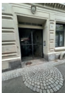
Slik ser inngangen til Eiriks gate 2 ut i 2021.
