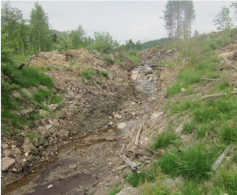
Figur 21: Denne dreneringsgrøfta går gjennom hele området i og langs det som er igjen av det som på kartet er benevnt «Storemyr».
