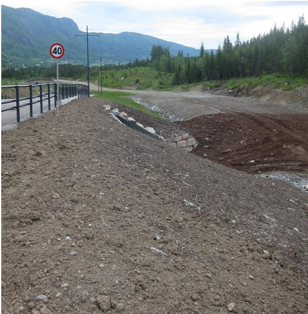
Figur 24: Bildet viser skikulvert som gir tilkomst vest i planområdet, og den nye skiløypa langs hovedveien, mellom Fyri/tilbringerheisen og sentrum.
