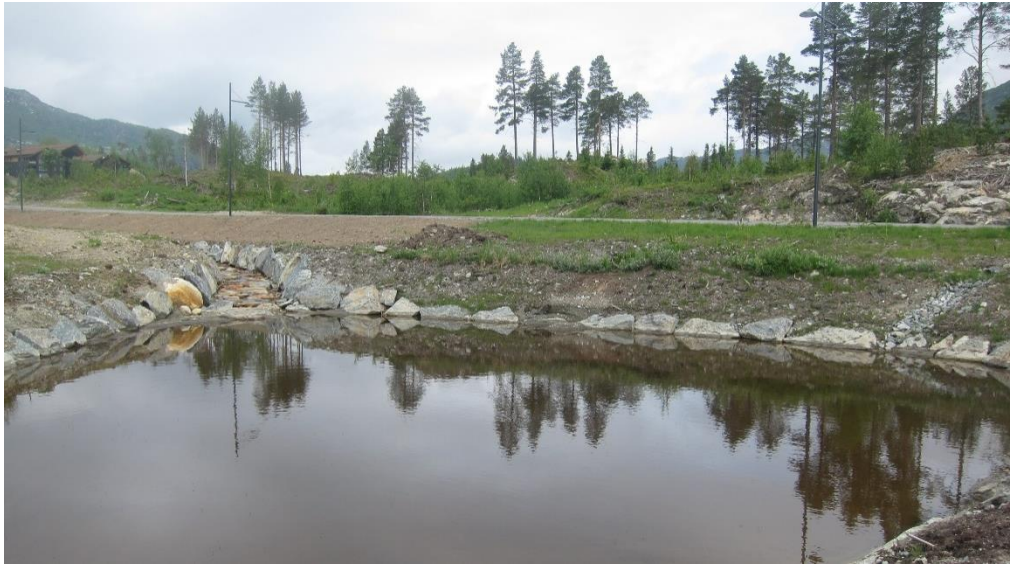
Figur 19: Bildet viser opparbeidet åpen løsning for overvannshåndtering. Planområdet sees i bakgrunnen, Fyri hotell lengst til venstre. Dette er det østligste dammen vist i figur. 13.
