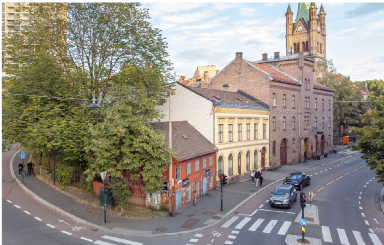
Det lille, røde huset på Grønland i Oslo er eid av kommunen og har stått tomt i snart 15 år. Da flyttet foreløpig siste leietager ut, men uten at kommunen har prioritert å rehabilitere det. Foto: Hans O. Torgersen
