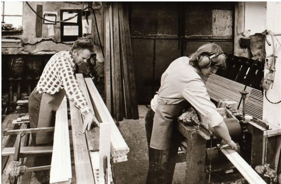
Arne Aunan og Dagfinn Pedersen påfører lim og setter sammen det som senere skal bli profilhøvlede trekjerner til glassfiberski. Legg merke den hydrauliske blokkpressen til høyre på bildet. Bak ser vi også dørene til varmeskap. Bilder er sannsynligvis tatt i 1974 og er utlånt av Signe Aunan.
