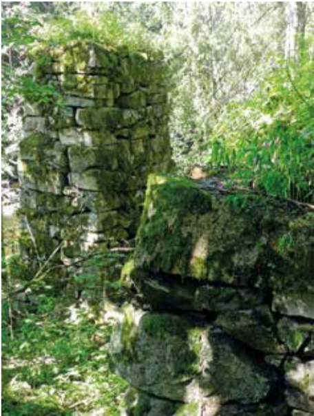
Den sju meter høye steinsøylen og støttmurene står i dag igjen etter oppgangssaga Holte sag. Foto John Tibballs
