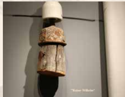
Stolpehatten kalt «Keiser Wilhelm». Med isolator av porselen.
