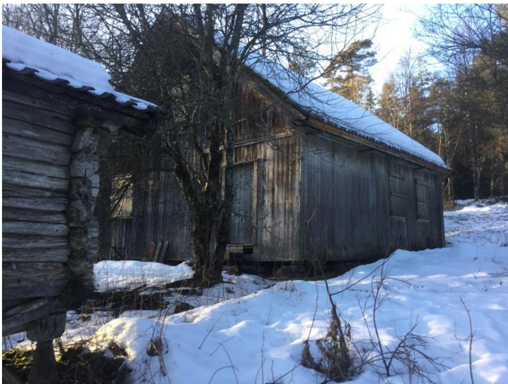
Våningshus før oppstart 2020
