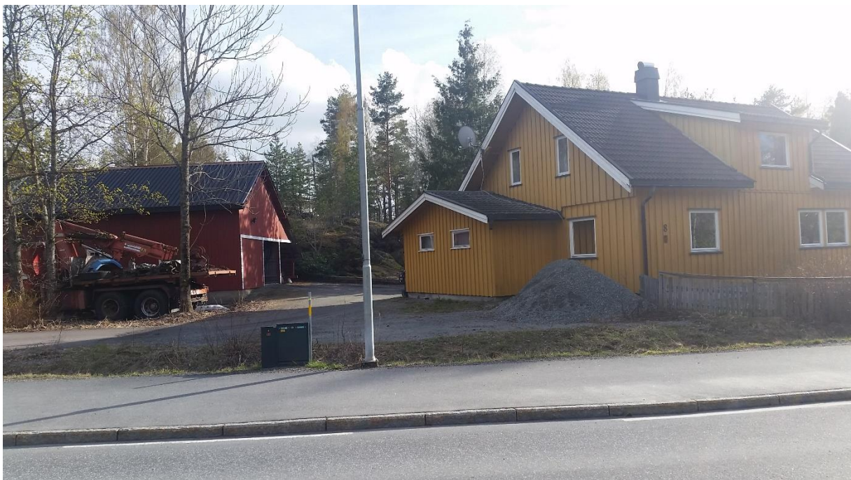
Huset og eiendommen i 2021 (Foto: Dag Kristoffersen)
