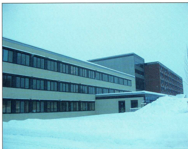
Sykehusets byggeprosjekt- Ny nordfløy- nærmer seg slutten, og flytting av enkelte aktiviteter vil skje i løpet av februar/mars.
