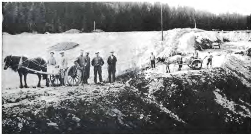
Fra byggingen av riksvei 120 gjennom Rælingen.
