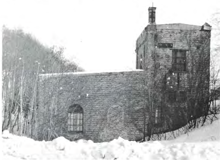
Rælingens første kraftstasjon i Nordbydalen.
