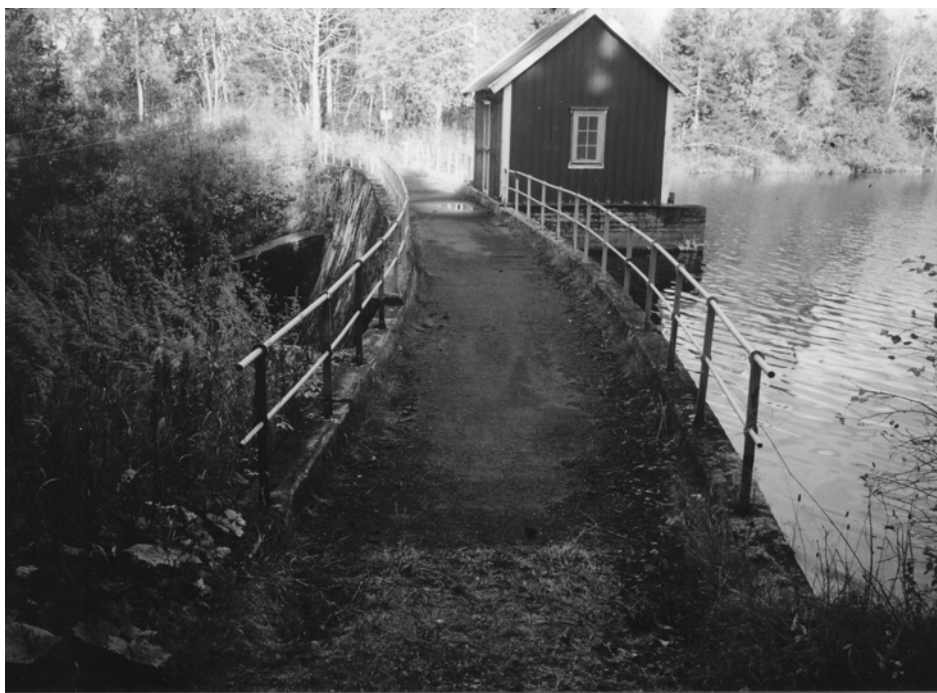
Tømmerholt dam på slutten av 1990-årene.
