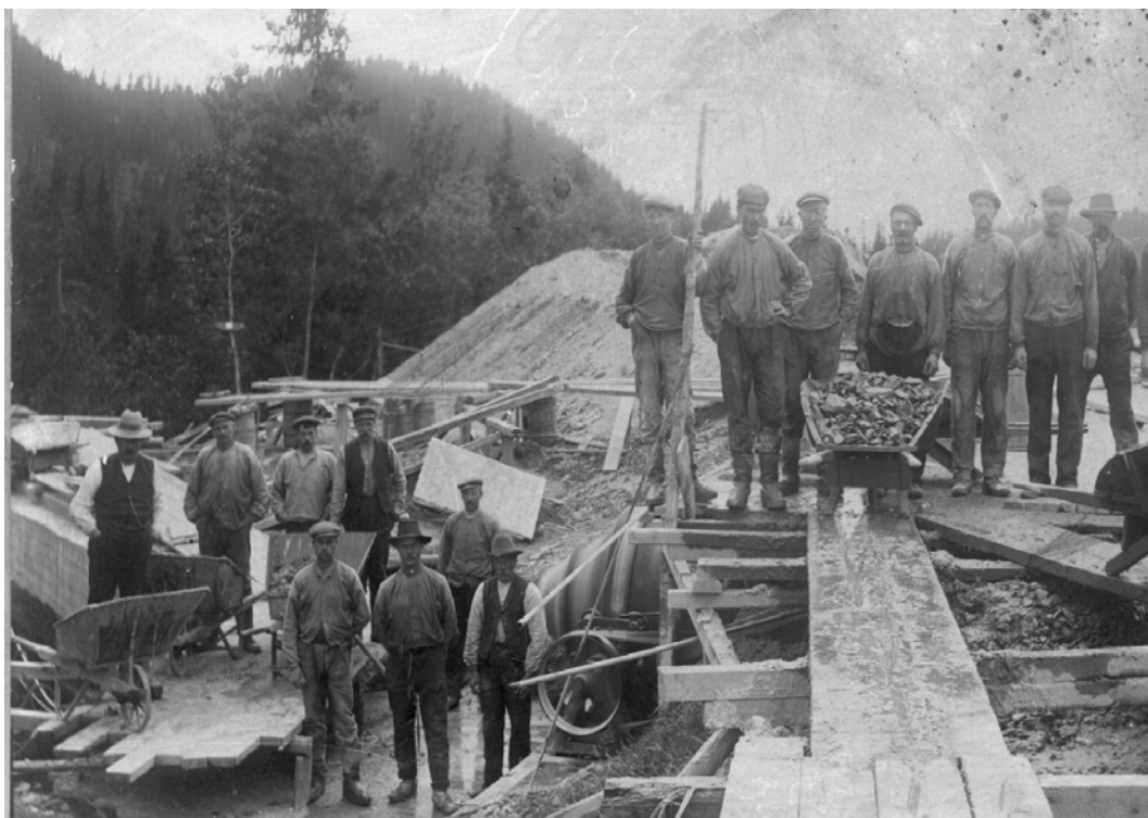
Fra byggingen av Tømmerholdtdammen. Mannen til høyre i første rekke er Emil Berg, som bodde på Bergli, tidligere Tømmerholtrø, gr. 43, bnr. 2.
