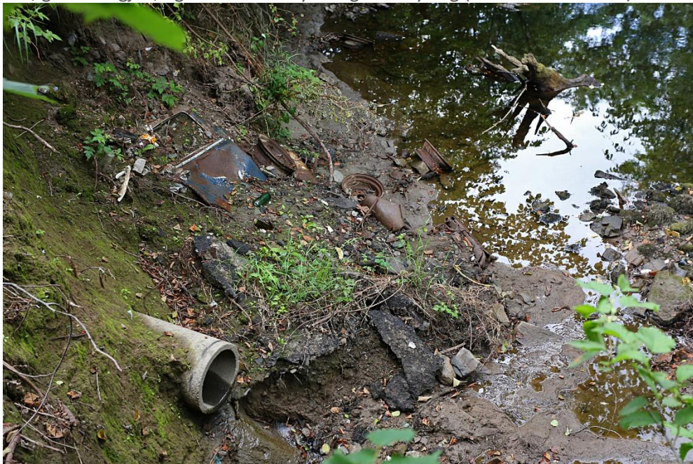
Figur 2. Eksempel på utfylling mot elv der urene masser er benyttet (fra område 4)
