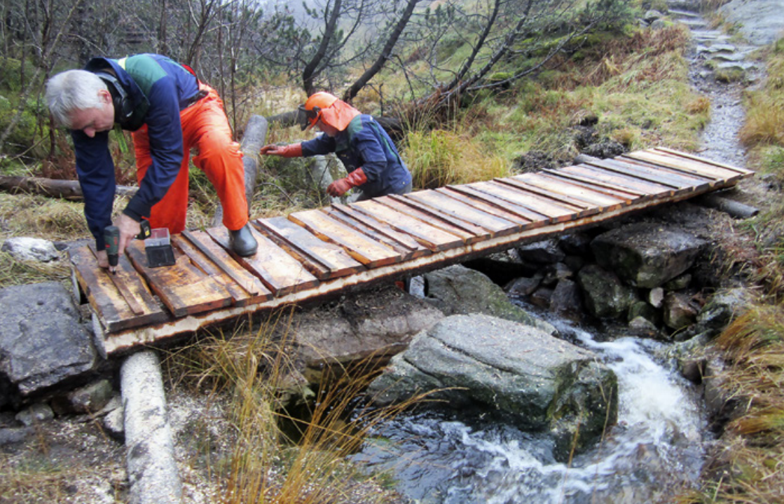
Dugnadsgjengen i arbeid med ny bro over Kvitursbekken.
