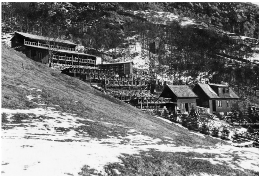
Minkfarmen som ble bygget opp etter flommen, ca. 1934.
