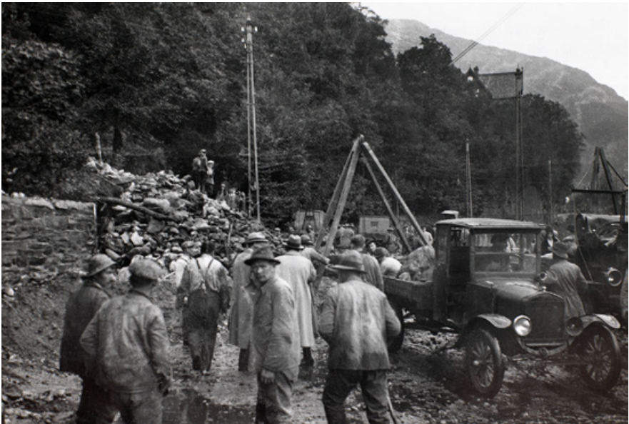
Opprydning etter flommen ved Kalvedalsveien.
