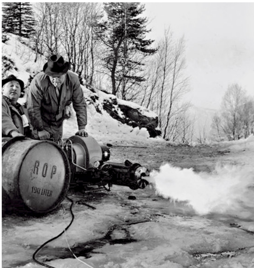
Politiet satte i gang smelting av snø i området der liket av den 14 år gamle jenten ble funnet i en kum ved Garpetjern mellom Eidsvåg og Munkebotn.
