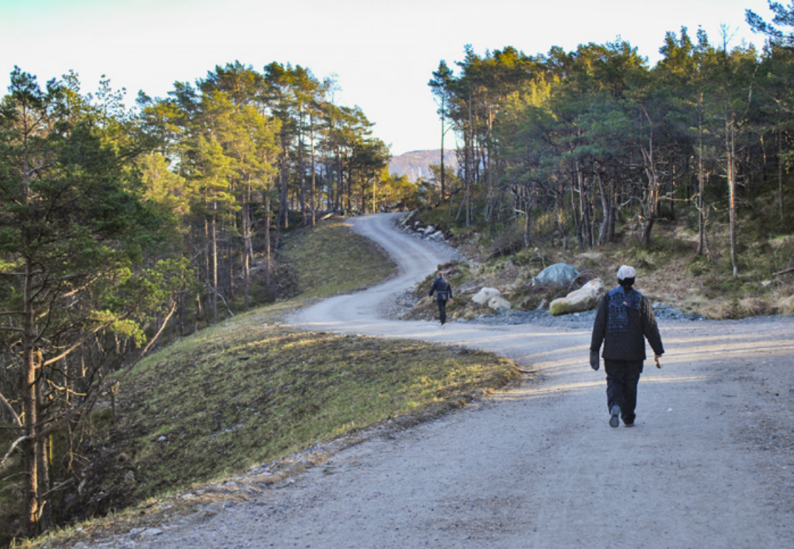
Fra den nye skogsveien på Eidsvågsfjellet.
