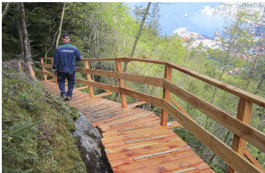
Dugnadsgjengen har bygget ny bro nord for Eventyrskogen.
