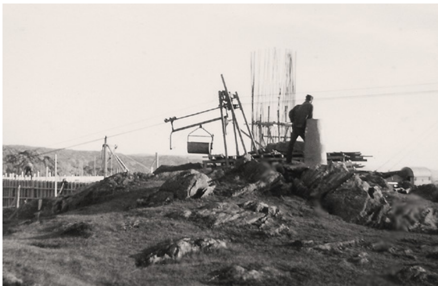
Under byggingen av TV-masten og Ulriksbanen brukte man en provisorisk anleggsbane fra foten av Montanabakken og oppover like sør for der Ulriksbanen går i dag.
