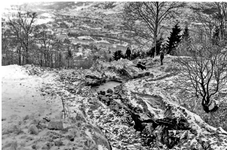
Vinteren 1979 gikk et snø- og slapseskred i Lægdebotnen. Broen i Skiveien ble skadd.
