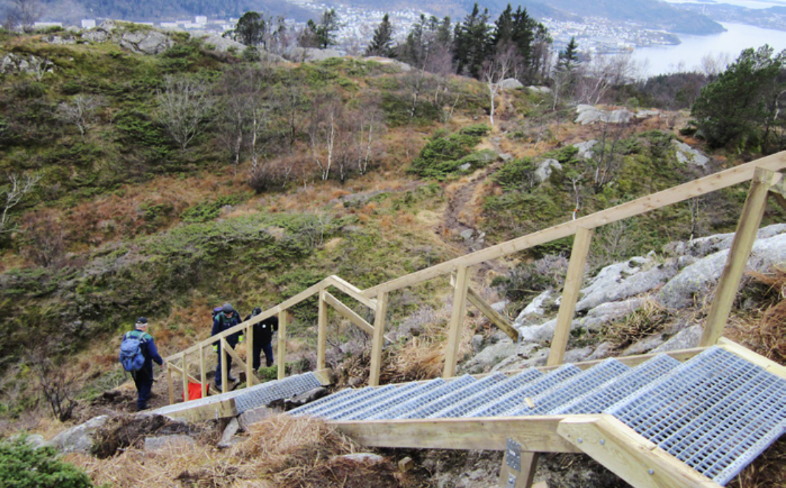
Den nye trappen til Fjellhytten sto ferdig i november.
