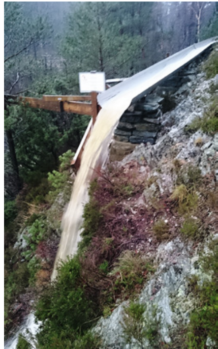
Bra sprut i enden av stålrennen.
