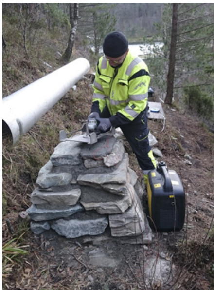
Kjell Helgesen tilpasser høyden på vuggen som rennen skal hvile i.
