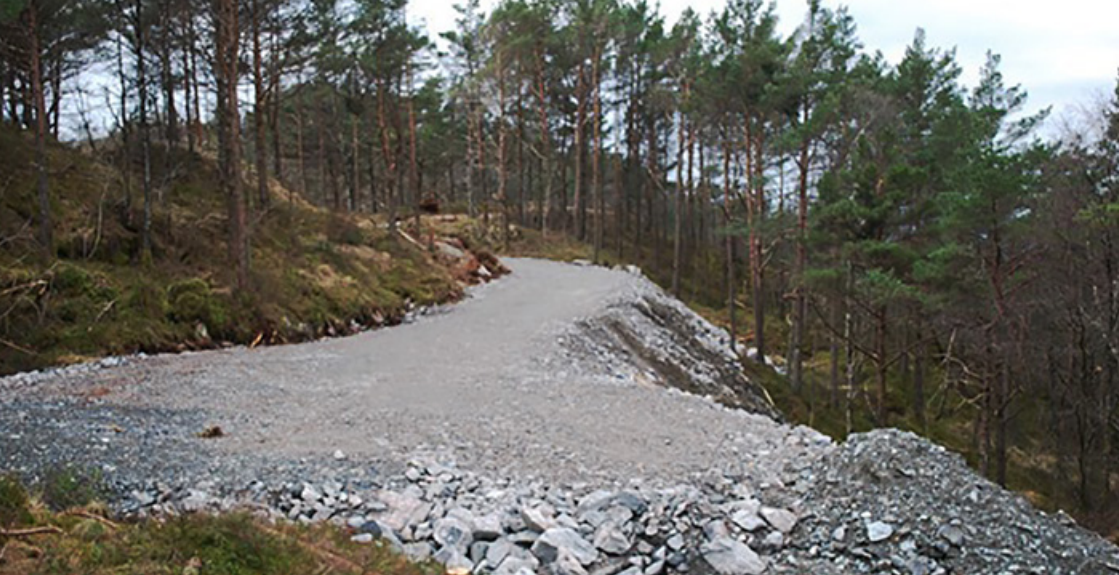
Turveien på Eidsvågfjellet slik den ser ut i dag.
