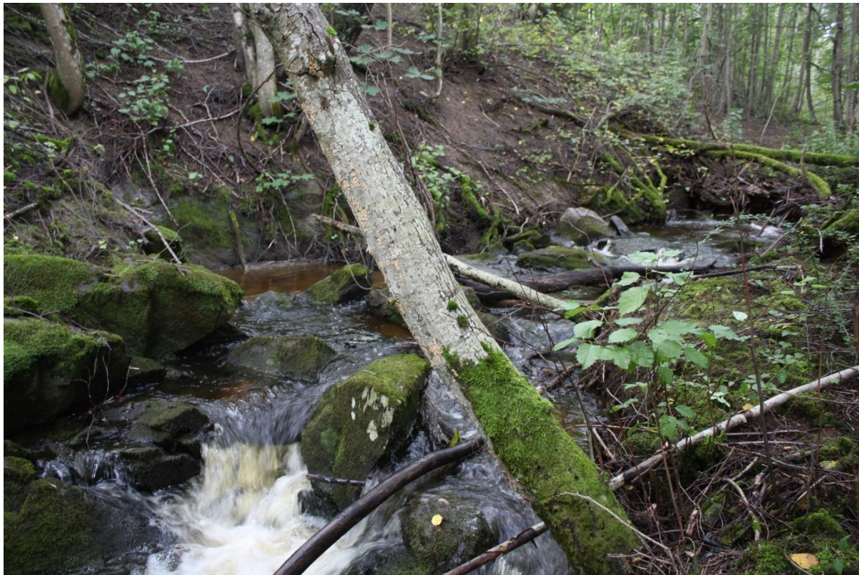
Foto 36: Østre del av demning id 266723, tatt mot syd.
