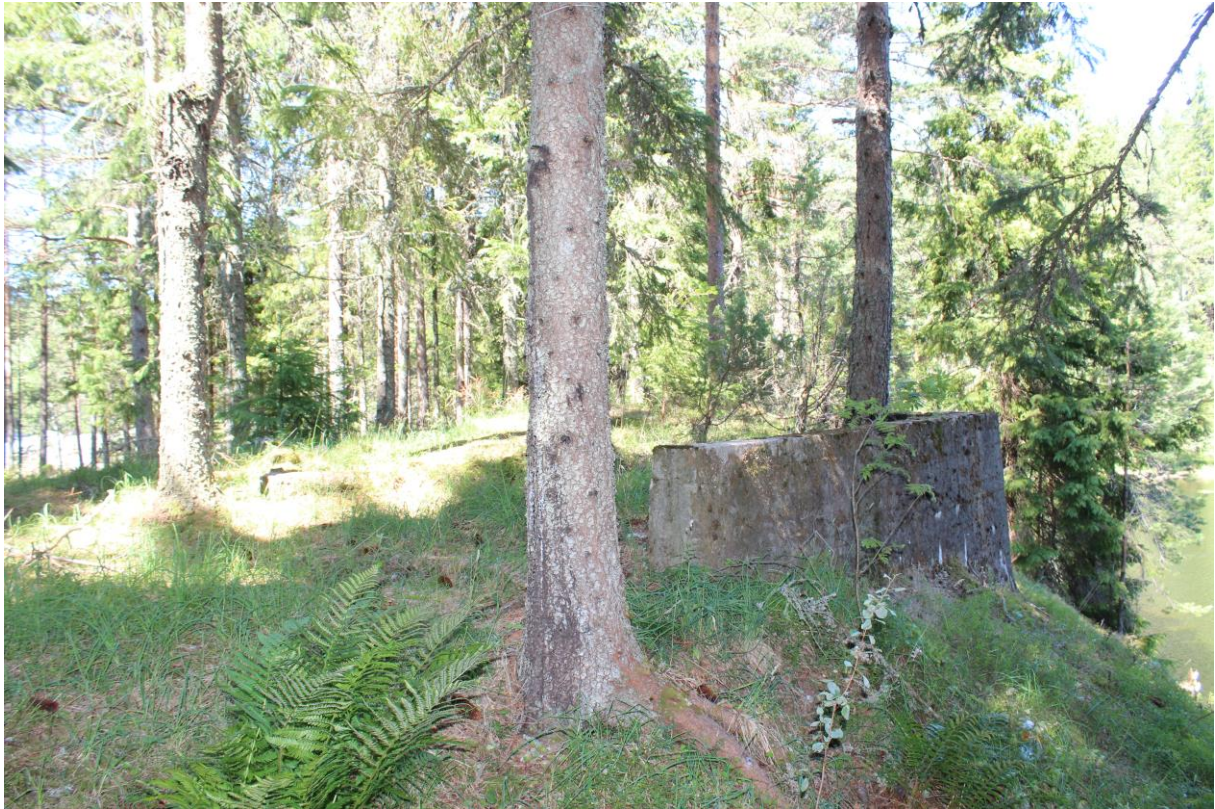
Figur 21: Betongmur i vinkel ved feriekolonien. Tatt mot NNV.
