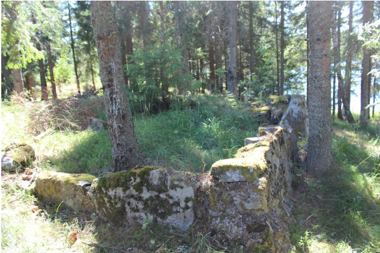
Figur 22: Sørøsthjørnet på grunnmuren etter feriekolonien. Tatt mot S.
