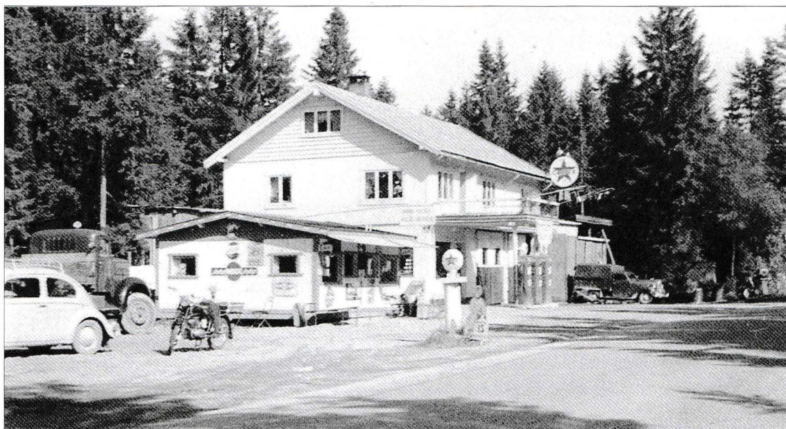
Løkka-verkstedet slik det fremsto i sine velmaktsdager. Verkstedet til Leif i bakgrunnen. Caltex-pumpa og kiosken som Camilla styrte. Bildet utlånt av Berit Mårud.
