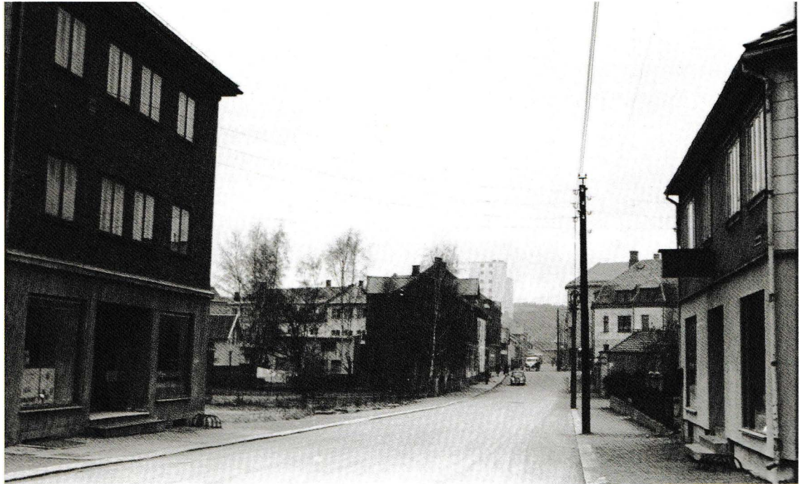
Til venstre nybygd forretningsgård, David Blids gate 18. Til høyre gammel forretningsgård, David Blids gate 23, som nå rommet Harald Kristiansens elektriske forretning. Bildet er tatt rundt 1950 og utlånt av Ole Laurits Mysen.
