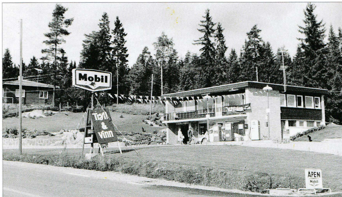
Den nye bygningen til Bakke fra 1964 med butikk, postkontor, leilighet og Mobil-stasjon. Bildet er tatt i 1965. Foto utlånt av Kjell Bakke.
