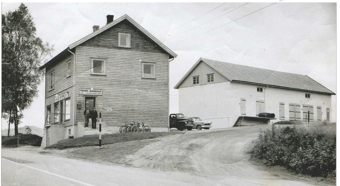
«Fram» etter byggingen av nytt lager med fryseri i 1958. Bildet er fra 1961. Bildet utlånt av Eva Vammeli.
